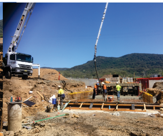
Pouring Base slab
