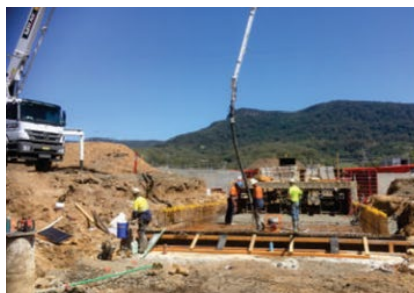
Pouring Base slab
